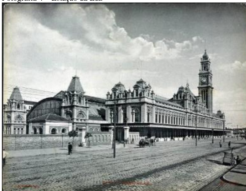
Fotografia 4 – Estação da Luz
